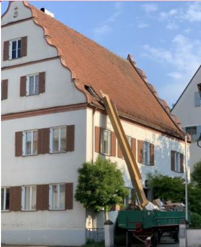
Säuberung Dachboden Pfarrhof
