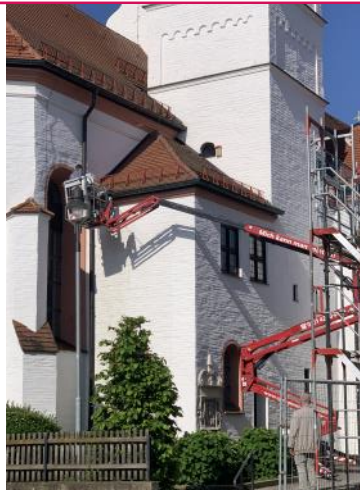
Säuberung Dachrinne Kirche
